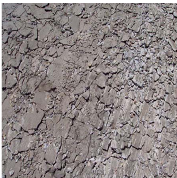
Rysunek 3. Nawierzchnia przed zagęszczeniem po wykorzystaniu MHB
