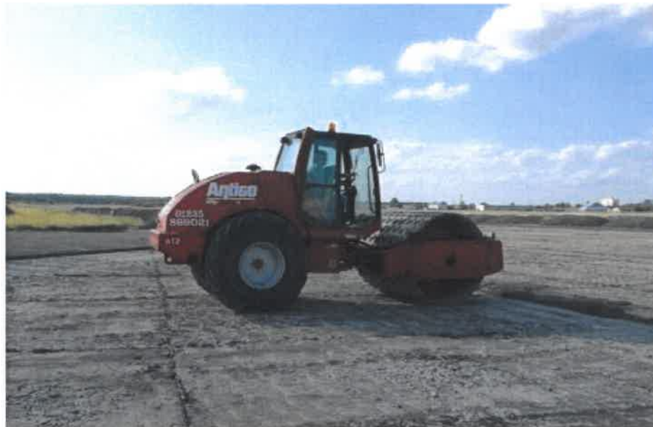
Rys. 2.2. Dokruszanie i dogęszczanie odprężonej warstwy walcem [źródło: archiwum ITWL]
