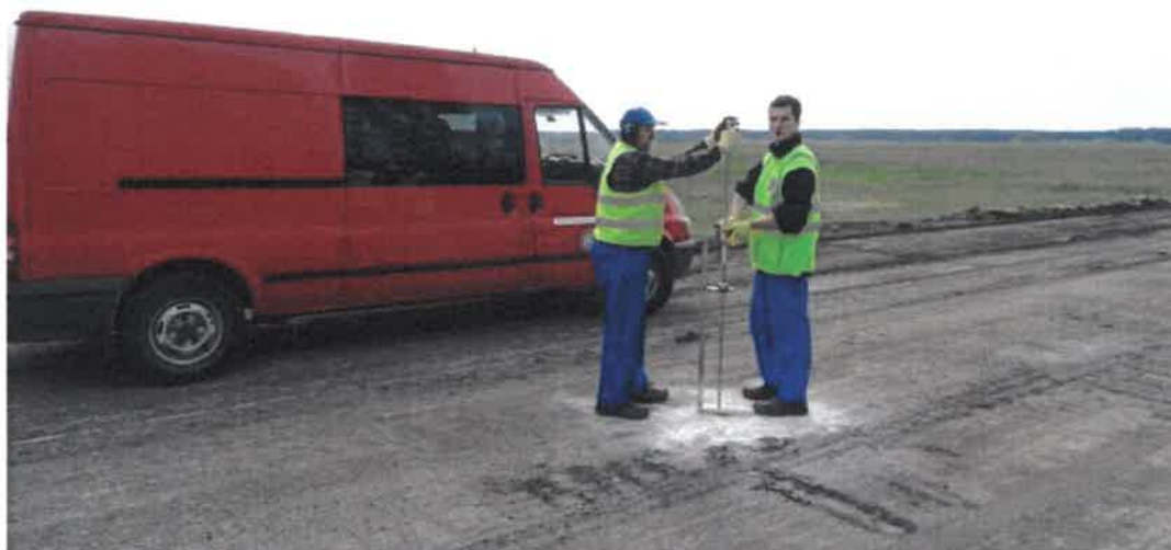
Rys. 4.4. Widok wykonywania badania nośności sondą SDS [źródło: archiwum ITWL]
