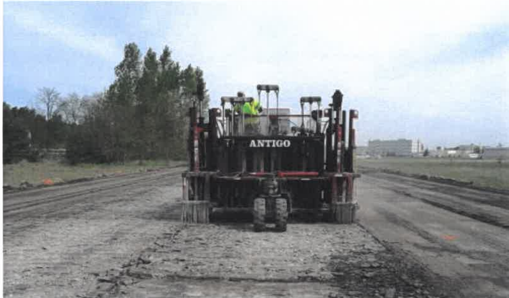
Rys. 2.1. Wielogłowicowy łamacz do nawierzchni MHB [źródło: archiwum ITWL]
