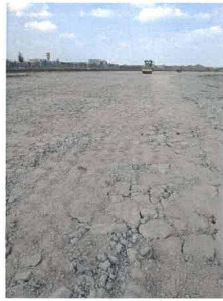
Rys. 4.3. Widok odprężonej warstwy z betonu cementowego [źródło: archiwum ITWL]
