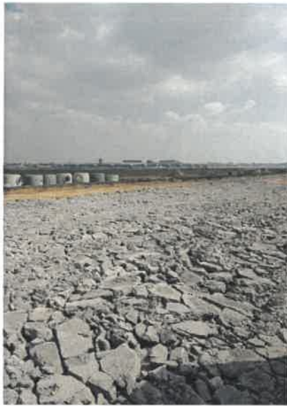
Rys. 4.3. Widok odprężonej warstwy z betonu cementowego [źródło: archiwum ITWL]
